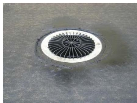
5. Так должна выглядеть воронка после укладки гидроизоляции
