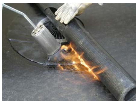
4. Наклеить 2-й слой гидроизоляции (до обжимного фланца)
