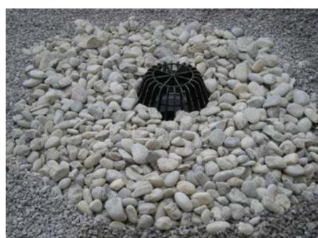
12. Засыпать гравием остальную поверхность кровли
