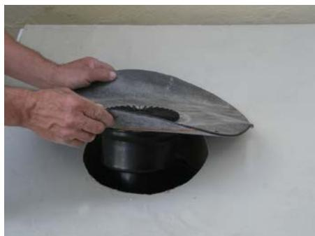
1. Проделать отверстие, нанести праймер, наклеить 1-й слой гидроизоляции.
