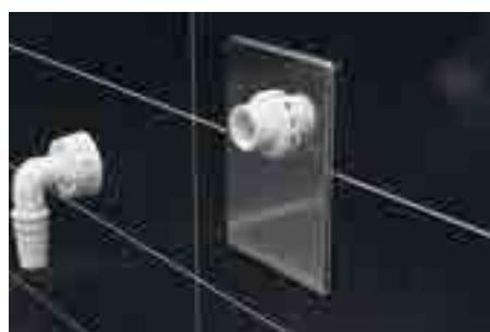
8. Установить лицевую пластину из нержавеющей стали и притянуть её с помощью резьбового крепёжного кольца, затем вручную прикрутить соединительный штуцер на резьбовой патрубок
