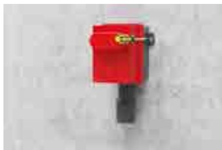
1. Определить место установки корпуса сифона и прикрепить его к стене
