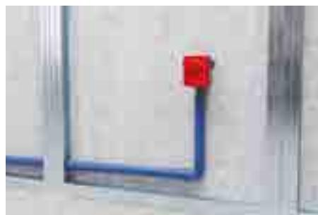
2. Соединить выпуск корпуса сифона с системой канализации.
