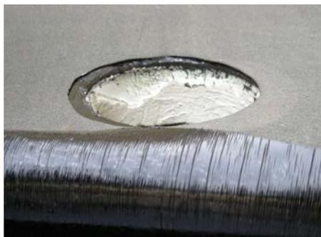
1. Просверлить отверстие Ø300 мм, поверхность покрыть праймером, уложить первый слой гидроизоляции и вырезать в ней отверстие Ø320 мм.
