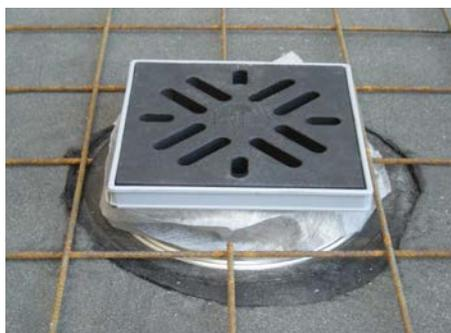
7. Надставной элемент обернуть фильтрующим материалом и уложить сетку из конструктивной стали
