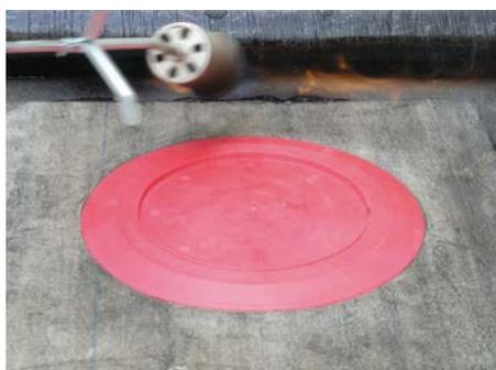
4. Второй слой гидроизоляции наплавляется на полимербитумное полотно трапа
