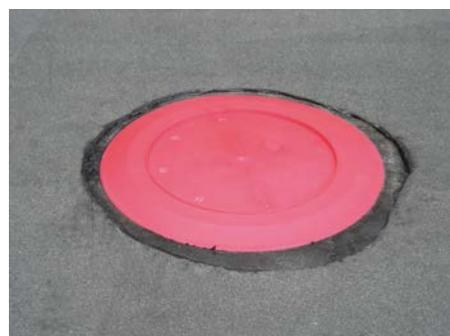
5. Так выглядит трап после укладки двух слоев гидроизоляции
