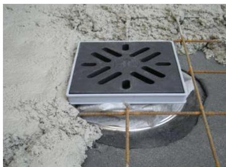
8. Залить бетонную стяжку
