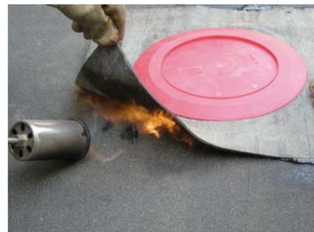
3. Приварить гидроизоляционное полотно трапа к первому слою гидроизоляции.
