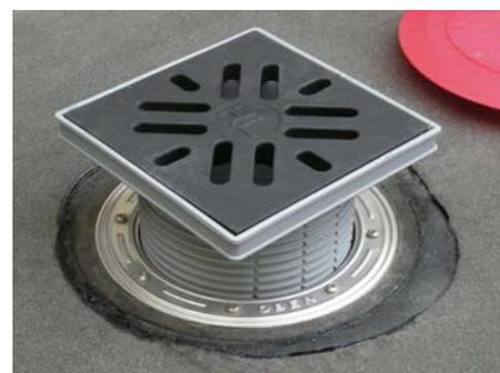
6. Убрать монтажную заглушку, вставить надставной элемент, при необходимости подрезанный по высоте до уровня чистового пола
