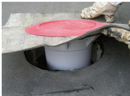
2. Установить в отверстие корпус трапа HL616H с монтажной заглушкой
