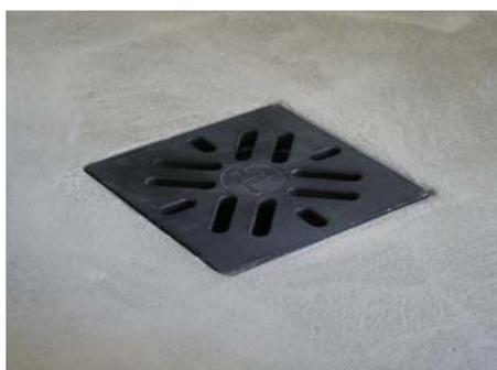
10. В подрамник надставного элемента установить решётку трапа
