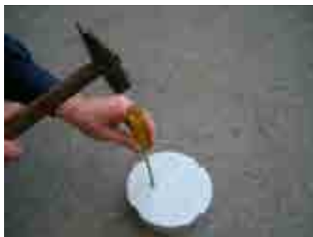
2. В монтажном элементе подготовить отверстия нужного диаметра
