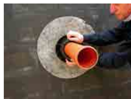
6. Затянуть фиксирующую гайку
