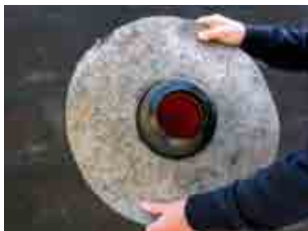
2. Надеть гидроизоляционную мембрану
