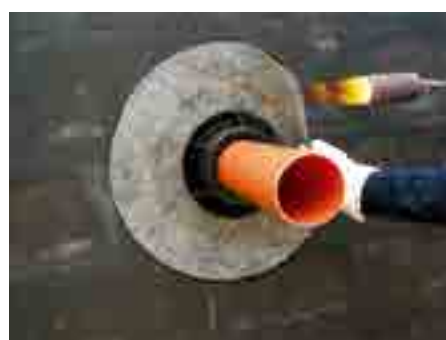
5. Приварить мембрану к битумному покрытию стены
