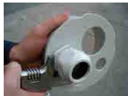
3. Установить и зафиксировать кабельные вводы.
