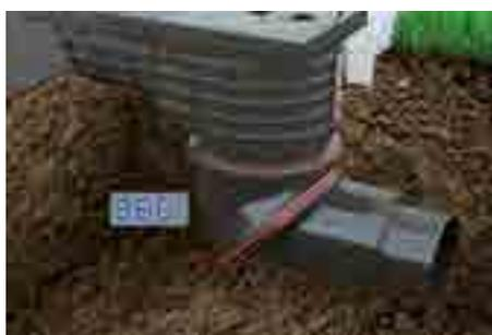
4. Отрегулируйте направление и угол установки выпускного патрубка
