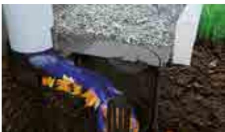
Лючок для прочистки и заслонка – с резиновыми уплотнениями, это предотвращает проникновение запаха из канализации, если выпуск дождеприёмника соединяется с общесплавной канализацией
