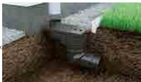
▲ Осенью водосточные системы систематически забиваются листвой и другим мусором, что затрудняет сток воды и приводит к намоканию фасада здания и образованию сосулек при перепадах температуры.
