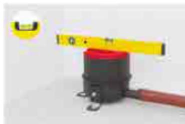
6. Установить корпус на заданную высоту, обеспечив нужный уклон отводящего трубопровода.
