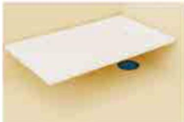
13. Установить душевой поддон на стяжку таким образом, чтобы корпус гидрозатвора находился над гибкой мембраной.
