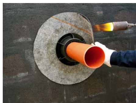
5. Приварить мембрану к битумному покрытию стены
