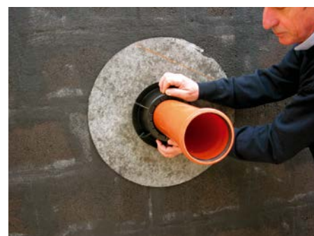
6. Затянуть фиксирующую гайку
