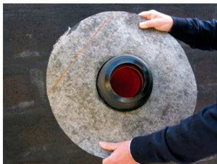
2. Надеть гидроизоляционную мембрану
