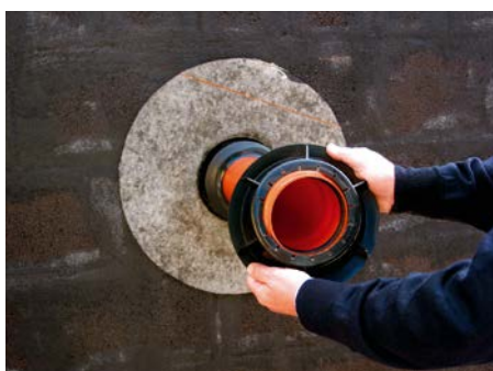
4. Установить фиксирующую гайку
