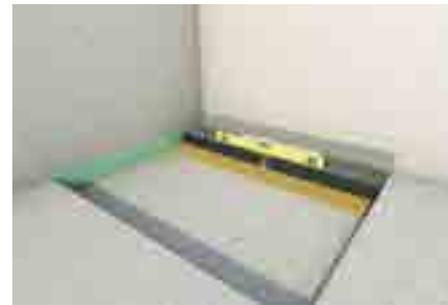
3. Установить душевой лоток на клеящий слой. Проверить горизонтальность установки в 2-х плоскостях.
