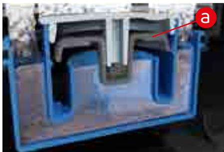
При стекании воды в лоток (трап) тарелка клапана (a) - поднимается вместе с уровнем воды
