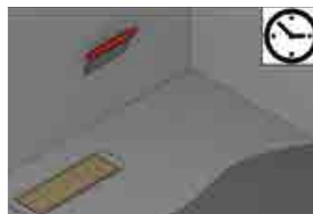
6. Установить монтажную заглушку для гидроизоляционного комплекта, нанести жидкую гидроизоляцию на поверхность стяжки, а также снизу и вверх полотна гидроизоляционного комплекта. Выдержать время для застывания жидкой гидроизоляции.
