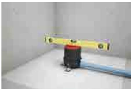
4. Регулировкой крепёжных уголков по высоте задать уклон трубы и проверить горизонтальность корпуса трапа
