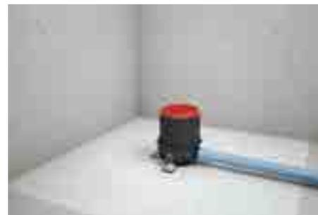
3. Установить трап, при помощи крепёжных уголков прикрепить его к основанию, соединить выпуск с системой канализации
