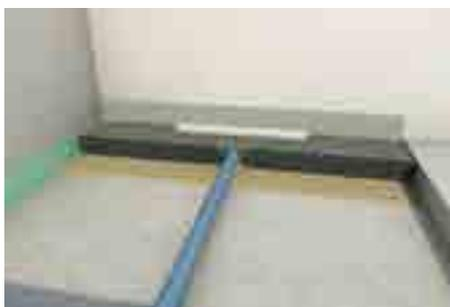
4. Соединить выпуск лотка с системой канализации.
