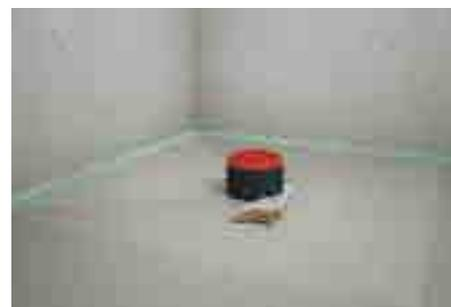
6. После застывания стяжки, выступающую часть корпуса трапа отрезать ножовкой
