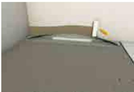
7. При помощи жидкой гидроизоляции приклеить армирующее полотно к стене.
