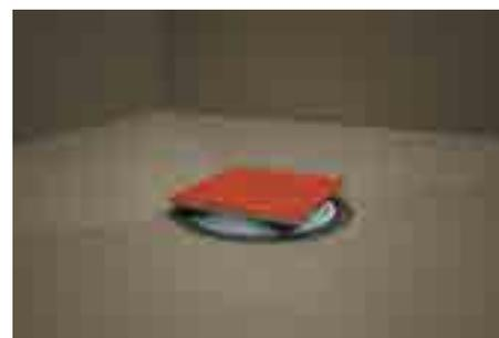
9. Установить подрамник с монтажной заглушкой в корпус. При необходимости укоротить подрамник по высоте.
