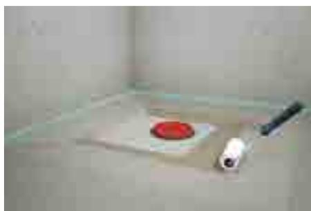
8. Нанести жидкую гидроизоляцию на поверхность пола, а также снизу и поверх фартука гидроизоляционного комплекта. Все стыки и примыкания проклеить армирующей лентой с помощью жидкой гидроизоляции.
