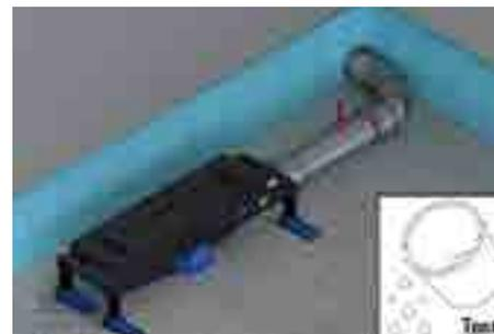
3. Соединить выпускной патрубок с системой канализации, теплоизолировать отводящий трубопровод.
