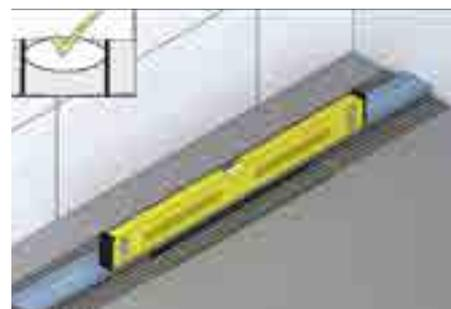
9. Решётку из нержавеющей стали вдавливать в слой плиточного клея горизонтально. Уклон в продольном и поперечном направлениях обеспечивается профилем решётки.
