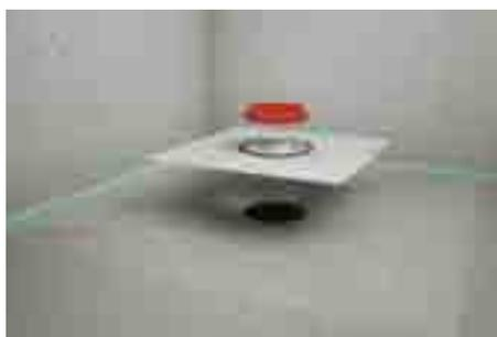
7. Установить комплект для гидроизоляции и монтажную заглушку
