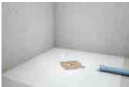
1. Определить место установки трапа, сориентировать монтажный шаблон в направлении выпускной трубы, наметить расположение крепёжных отверстий.
