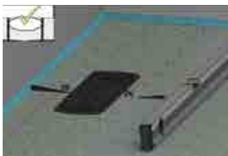
4. Залить стяжку с уклоном не менее 2% к монтажной заглушке установленной на корпус лотка.
