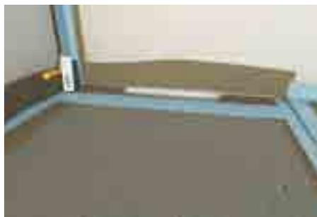
8. Все стыки и примыкания проклеить армирующей лентой с помощью жидкой гидроизоляции.
