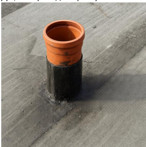
Рисунок 3 Нанесение битума на вертикальную трубу
