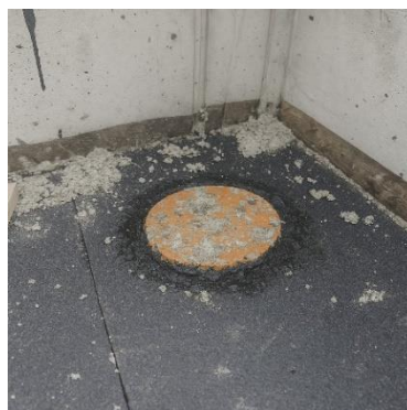
Рисунок 2 Герметизация раstra трубы вровень с плитой перекрытия гидроизоляционным составом (герметиком)
